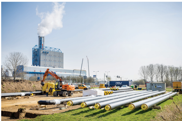
Aantakking warmtenet op AVR Duiven
