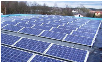
figuur 1, voorbeeld zonnepanelen in eenzijdige noord/zuid opstelling
