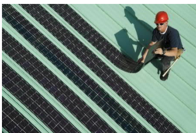
figuur 4, zonnefolie op plat dak
