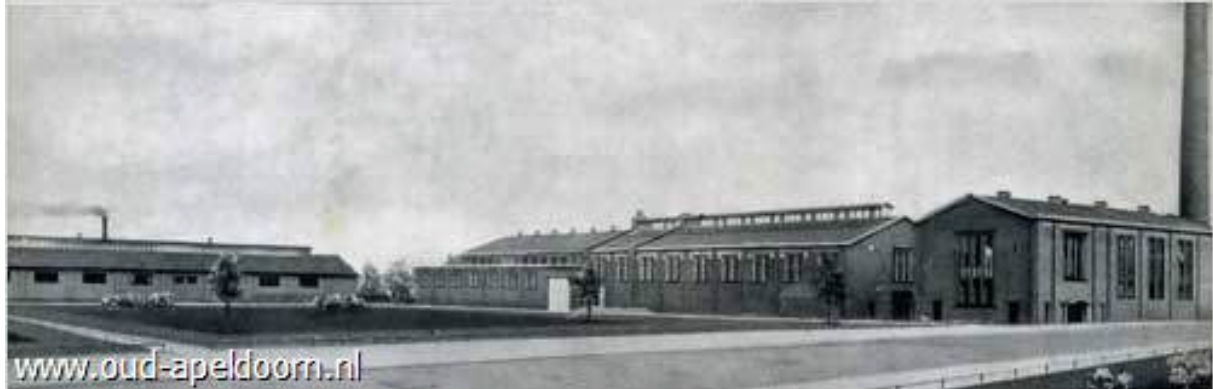
Het oudste deel van de fabriek, voor de productie van morfine, gezien vanaf de Vlijtseweg. Links de kafloodsen, in het midden de fabriek met extractie- en distilleerinstallaties en rechts het ketelhuis in de eerste opzet met schoorsteen. Op het terrein op de voorgrond verrees tussen 1950 en 1951 de fabriek met kantoor voor de Zwitsalafdeling.
